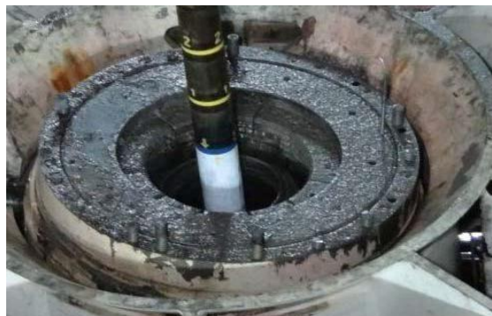
Mitad inferior del conector del LMRP que falló.
