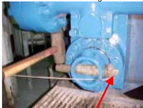
Nuevo punto de fijación para una línea de seguridad
