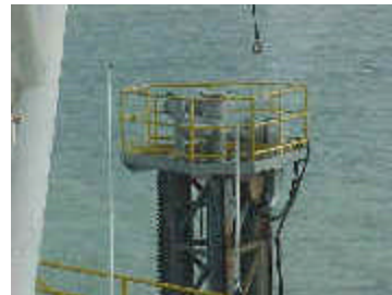
Nro. 2 – Vista de la Torre de Pozo Profundo desde el Operador de la Grúa de la Torre
