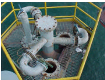
Nro. 1 - Plataforma de corona de la Torre de Pozo Profundo
