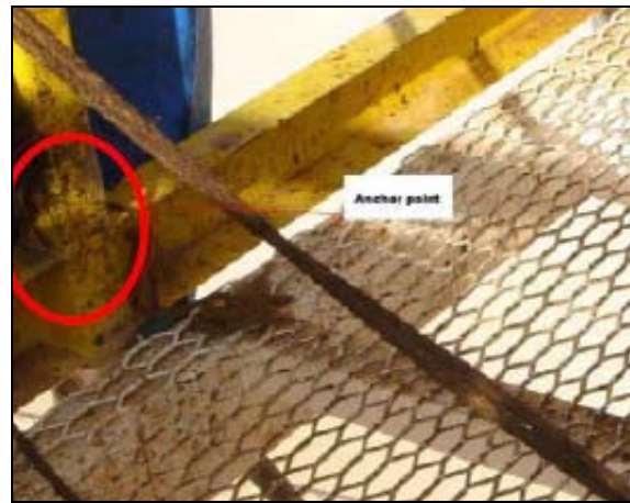
Punto de fijación en el pasamanos. Punto de anclaje.
