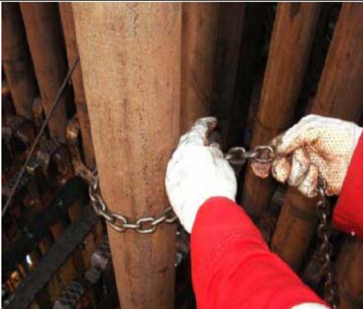
Demostración de la colocación de la cadena en la tubería.
