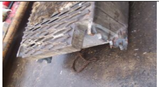
Vista de los ojillos de platillo rotos en la plataforma de parada
