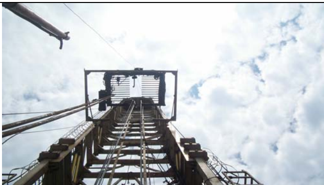
Vista de la plataforma de parada (diving board) faltante
