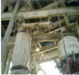
[Figure 1] Situación de la grúa en altura
