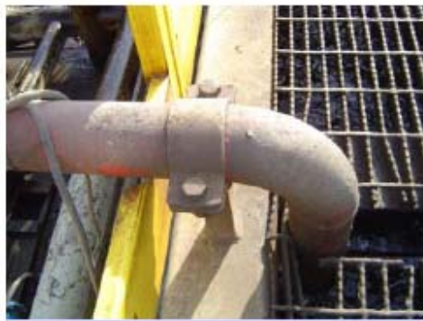
Configuración normal del soporte de anclaje de la Bomba de Lodo
